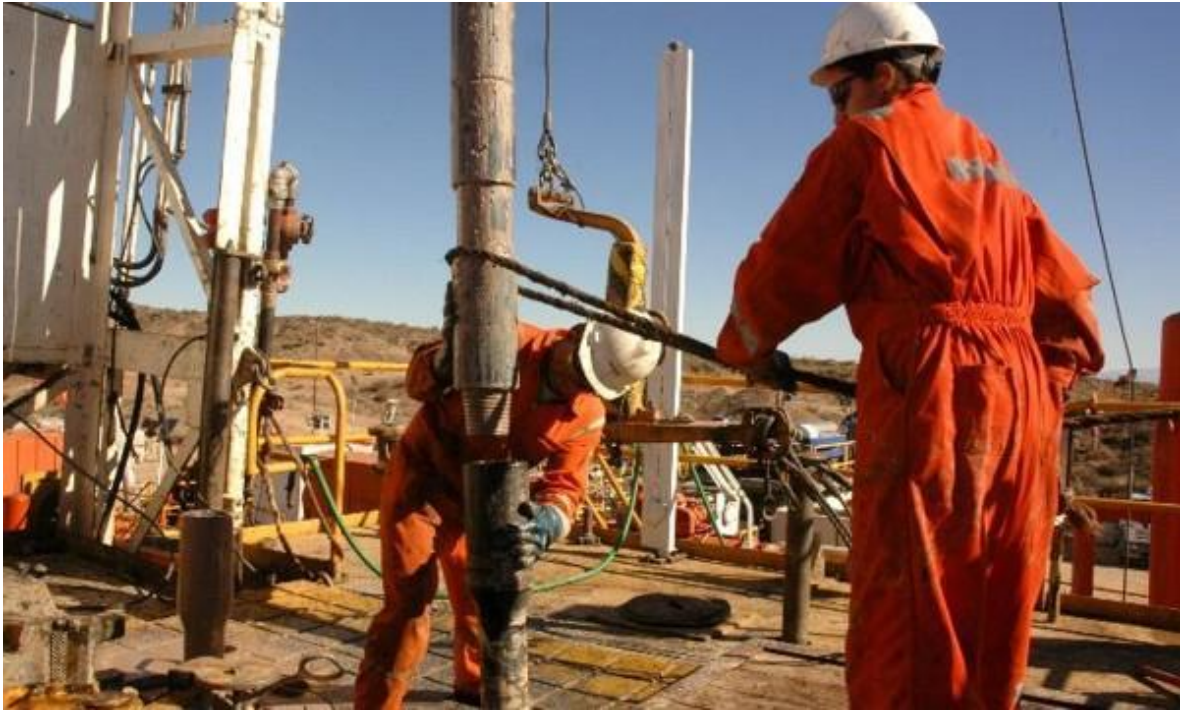
Equipos pozo petrolero. (Tomada de https://claudioantonioramirezso.com/wp-content/uploads/2021/02/Mantenimiento-de-pozos-petroleros-Claudio-Antonio-Ramirez-Soto.jpg )
