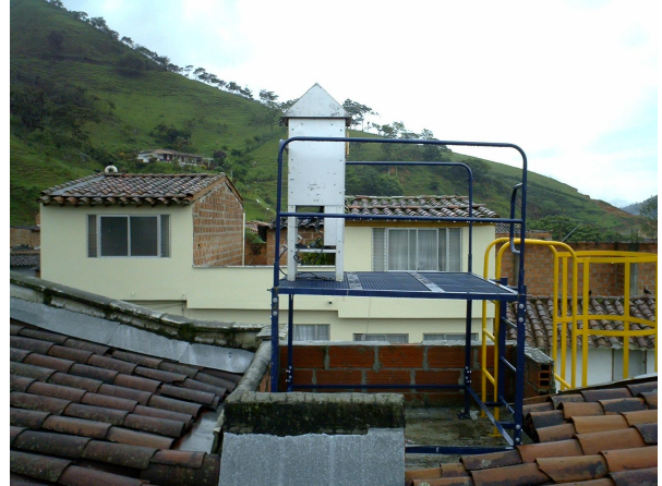
Foto 9. Estación de Barbosa, después de la reforma y nueva ubicación
