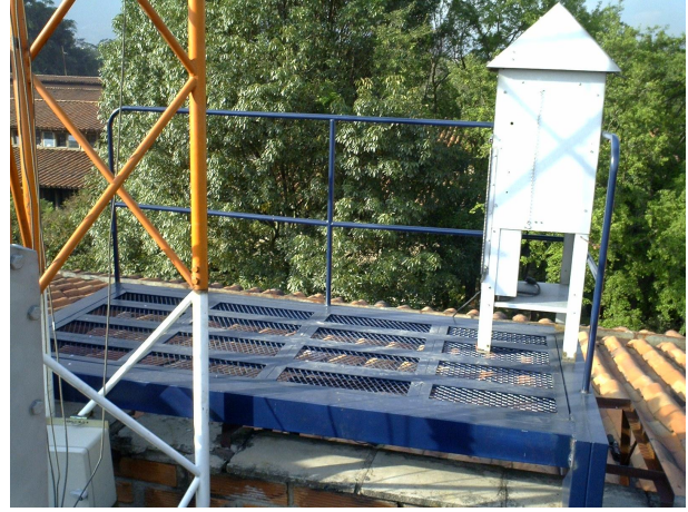
Foto 19. Estación, Universidad de Antioquia, después de la adecuación
