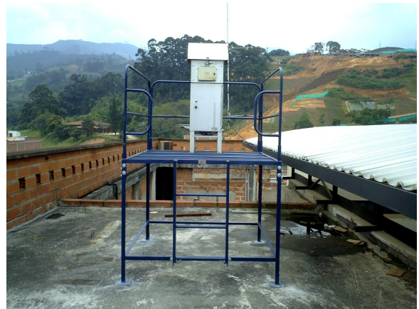
Foto 11. Estación Sabaneta, después de la adecuación
