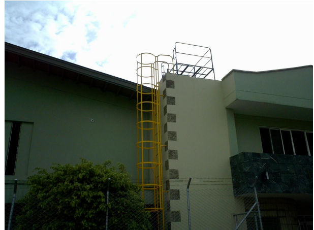
Foto 6. Estación de Barbosa, adecuación de acceso a la terraza.
