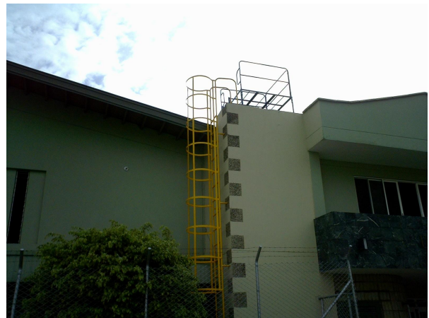
Foto 15. Estación Barbosa, adecuación de acceso a la terraza donde se encuentra el equipo de Hi-Vol.
