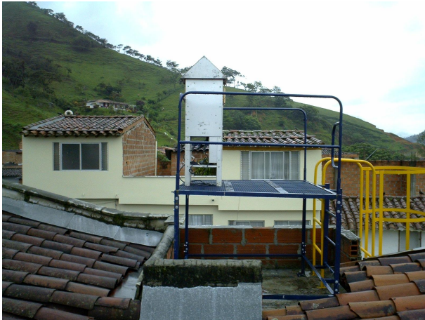
Foto 1. Estación de Barbosa
