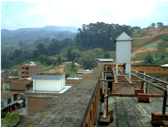
Foto 10. Estación Sabaneta, antes de la adecuación.
