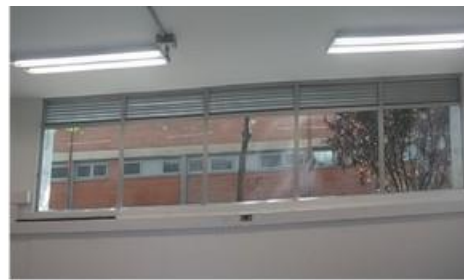
Obras civiles para el laboratorio de diseño mecánico (Incluye mobiliario)
