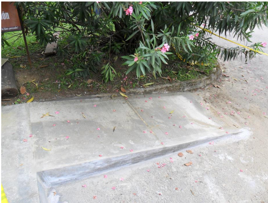
Foto 3: Adecuación rampas para personas movilidad reducida Facultad de Minas
