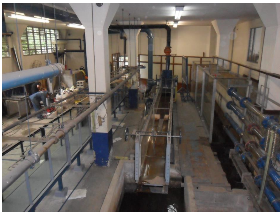
Foto 10: Laboratorio de olas marinas en unidad de Hidráulica – construcción-
