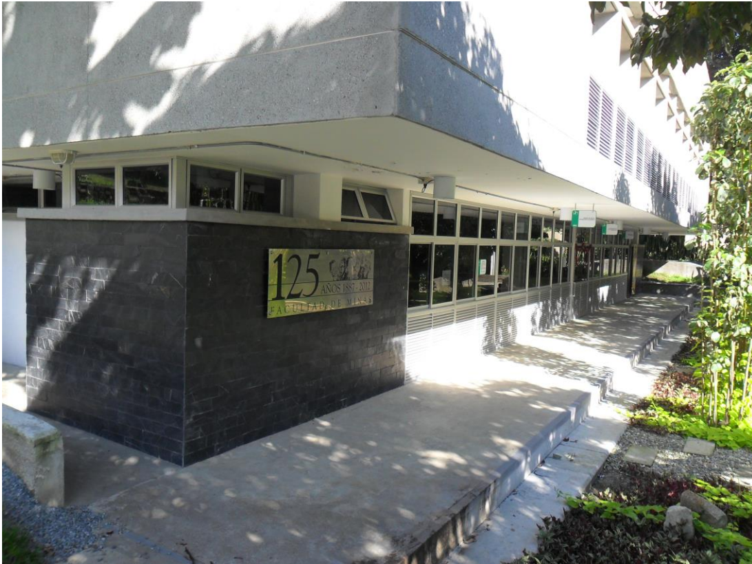
Foto 7: Adecuación Bloque M4. Edificio Académico Administrativo
