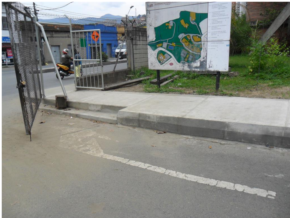
Foto 8: Construcción salida/entrada peatones M1.
